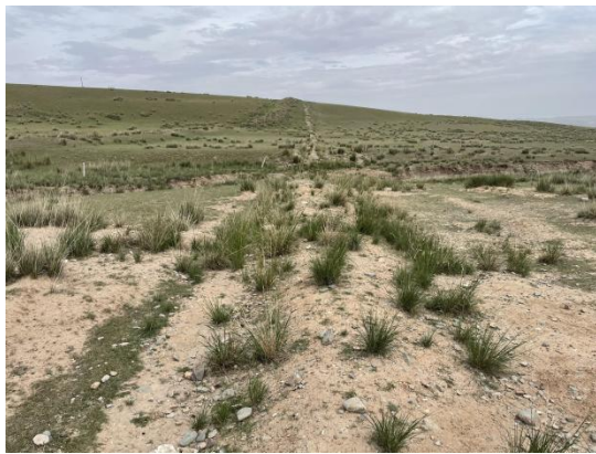
管线及施工便道植被恢复状况
